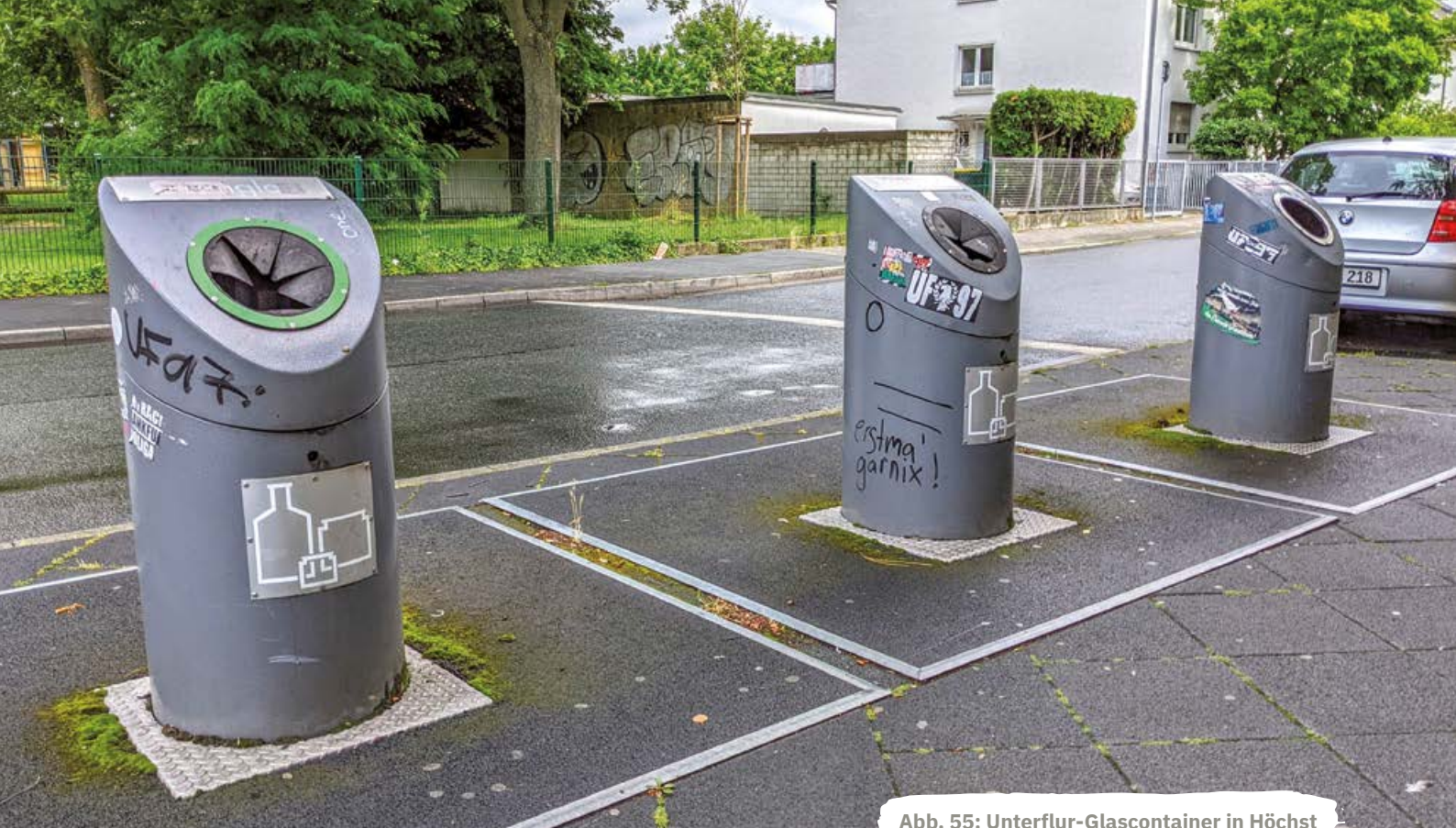
Abb. 55: Unterflur-Glascontainer in Höchst
