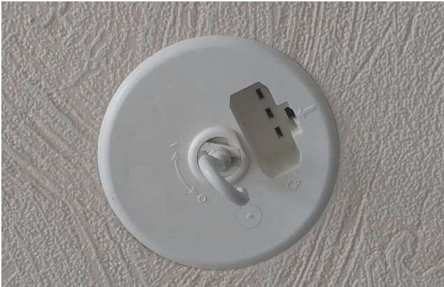
Bild 1: Handelsübliche Leuchtmittelinbaudose eines französischen Herstellers
