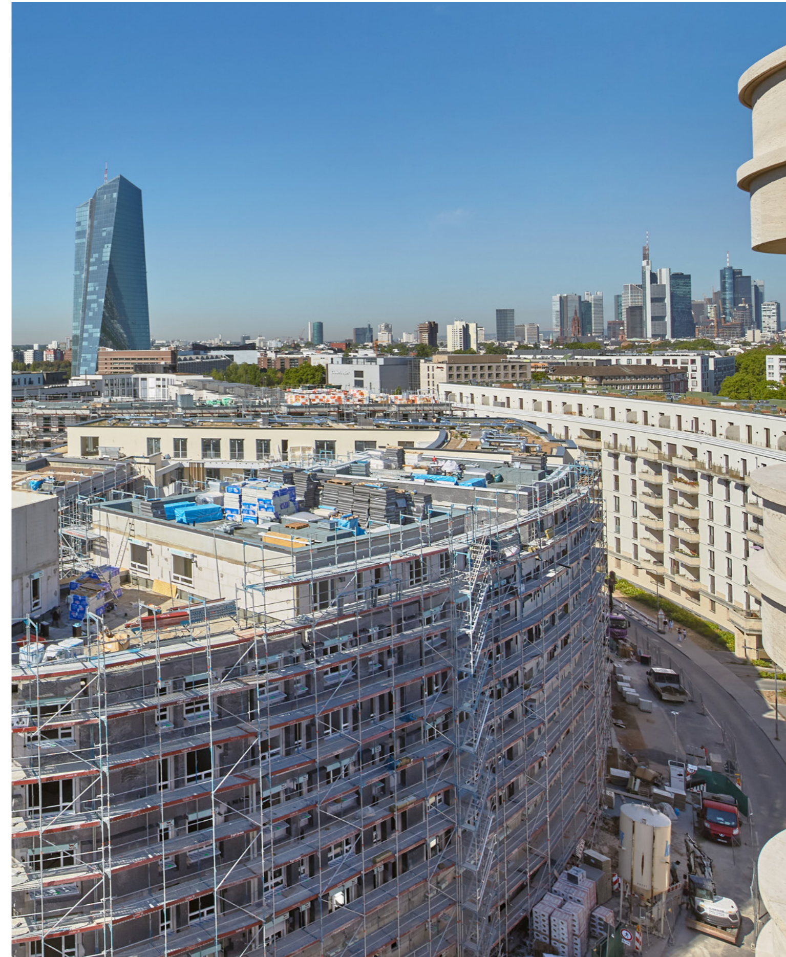
Im Ostend entstehen in der Launhardtstraße 119 geförderte Wohnungen
