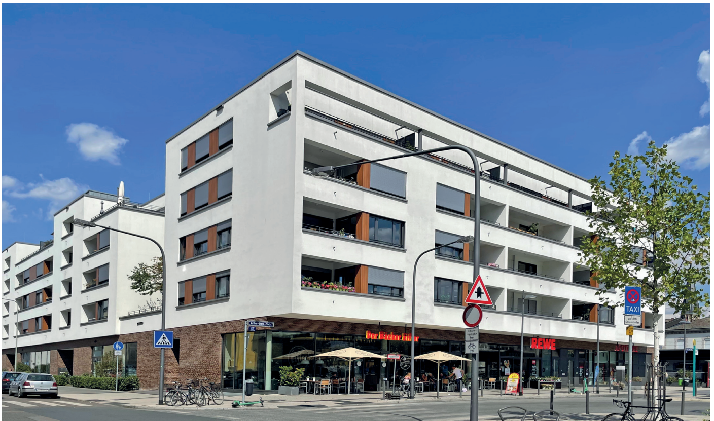
Supermarkt, Bäckerei und Apotheke mit überbauten Wohnungen an der S-Bahn Haltestelle Rödelheim (Frankfurt am Main - Rödelheim, Breitlacherstraße 78)
