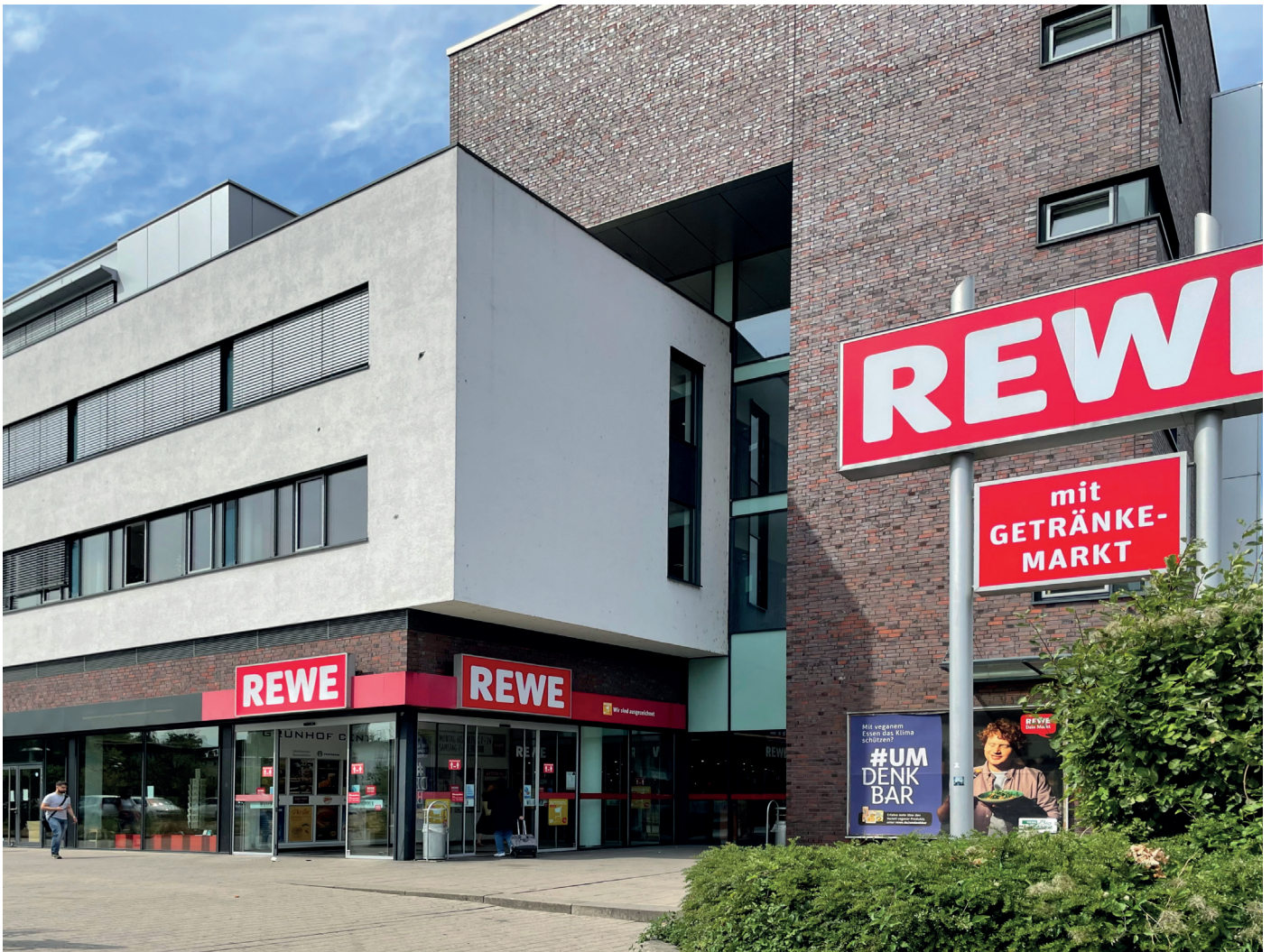
Neubau eines Supermarktes mit überbauten Wohnungen (Frankfurt am Main – Westend-Nord, Eschersheimer Landstraße 221)
