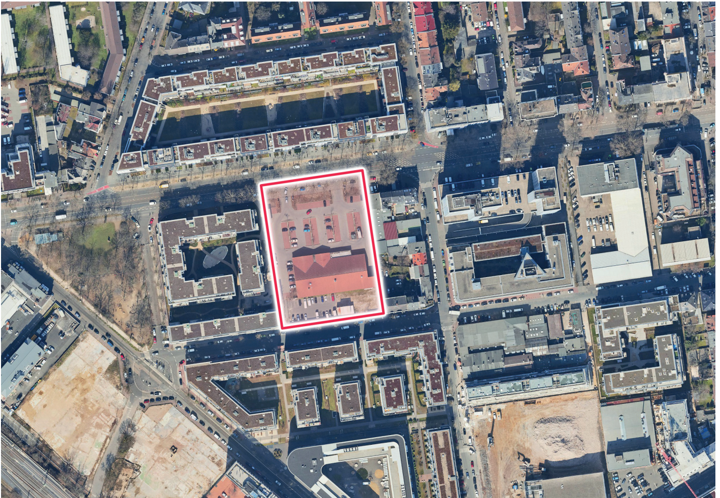
Ungenutzte Chance: eingeschossiger Supermarkt (Umrandung) inmitten eines hochverdichteten Siedlungsbereichs (Frankfurt am Main – Gallus, Mainzer Landstraße 377-385) © Stadtvermessungsamt Frankfurt am Main
