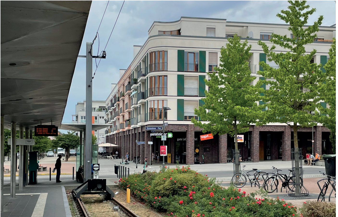
Tegut am Gravensteiner Platz: Orientierung des Eingangs auf den Fußgängerverkehr der Straßenbahn-Haltestelle und Bereitstellung von einfachen und überdachten Fahrradstellplätzen vor dem Eingangsbereich (Frankfurt am Main – Preungesheim, Gravensteiner Platz 4-6)
