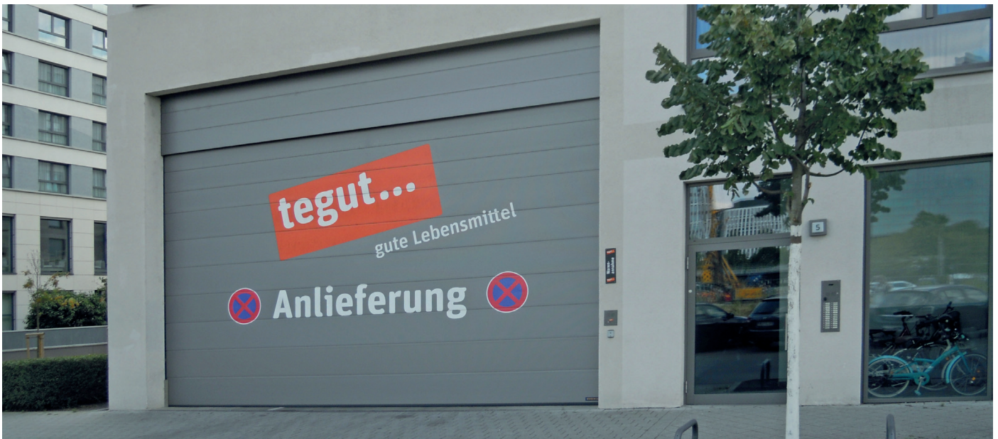
Lieferzone im Erdgeschoss, rückseitig integrierte Anlieferungszone (Frankfurt am Main – Bockenheim, Leonardo-da-Vinci-Allee 4-8)
