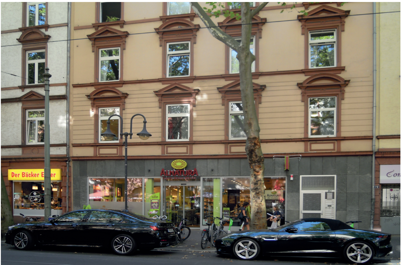
Integration von Einzelhandel in den Altbaubestand auf der Schweizer Straße (Frankfurt am Main – Sachsenhausen, Schweizer Straße 80)
