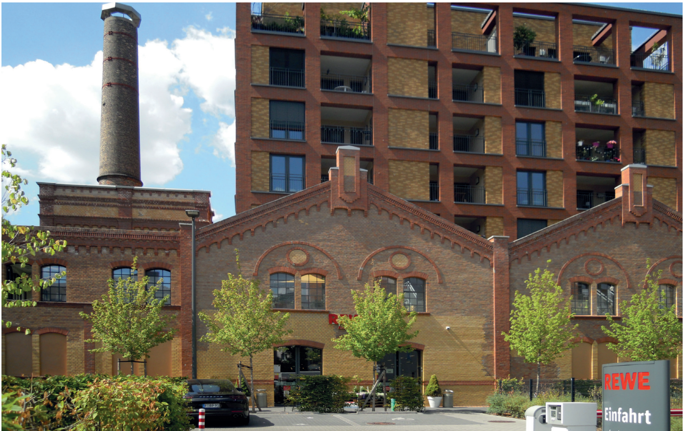
Integration eines Nahversorgers mit Anpassung an die Nachbarschaft, auch in der Materialität (Frankfurt am Main – Bockenheim, Kuhwaldstraße 61)
