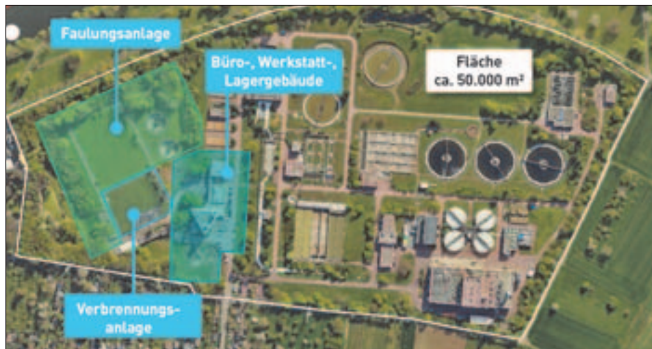
Ausbau und Erneuerung der Kläranlage geschehen auf dem vorhandenen Gelände. Der Schlamm, der nebenan bei der Abwasserreinigung sowie im Klärwerk Niederrad anfällt, kann so weiterhin direkt bearbeitet und die bestehende Schlammdruckleitung von der ARA in Niederrad nach Sindlingen auch zukünftig genutzt werden. Copyright: Stadtentwässerung Frankfurt am Main
