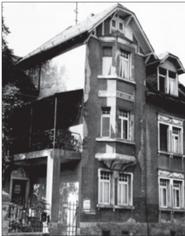
Die Aufnahme zeigt das ehemalige Haus des Arztes Günter Stollowsky, das dem Umbau des Kreisel's weichen musste. Foto: HGV
