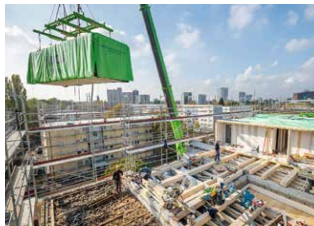
26 MODERNISIERUNG UND GROSSINSTANDHALTUNG Wohnraum on top
