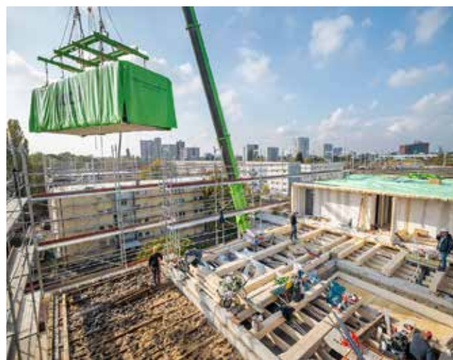
14 Häuser in der Frankfurter Fritz-Kissel-Siedlung werden mit Modulen aus Holz aufgestockt. So entstehen 82 neue Wohnungen.
