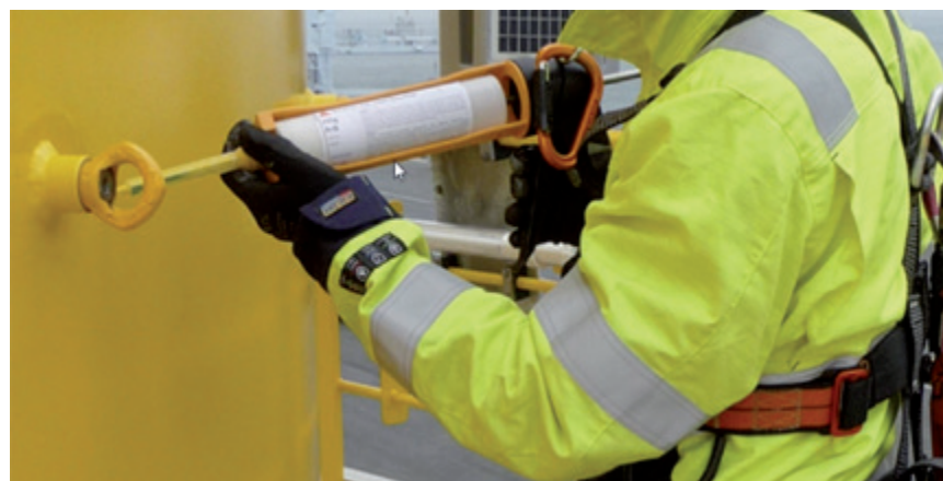
Abbildung 4.1.4.1 Kartuschensystem als umweltfreundliches Reparaturbeschichtungssystem
