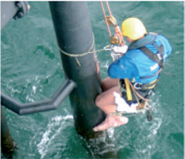
Abbildung 4.1.6.1 Wartungsarbeiten an einem Offshore-Bauwerk.[2]
