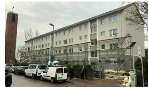
Im Wohngebäude am Judensand werden 24 Wohneinheiten in Mainz von Energieeffizienzklasse F auf B gesteigert und von einer Nachverdichtungsmaßnahme begleitet.
