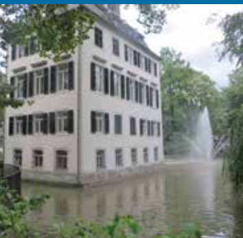
Holzhausenschlösschen mit Fontäne
