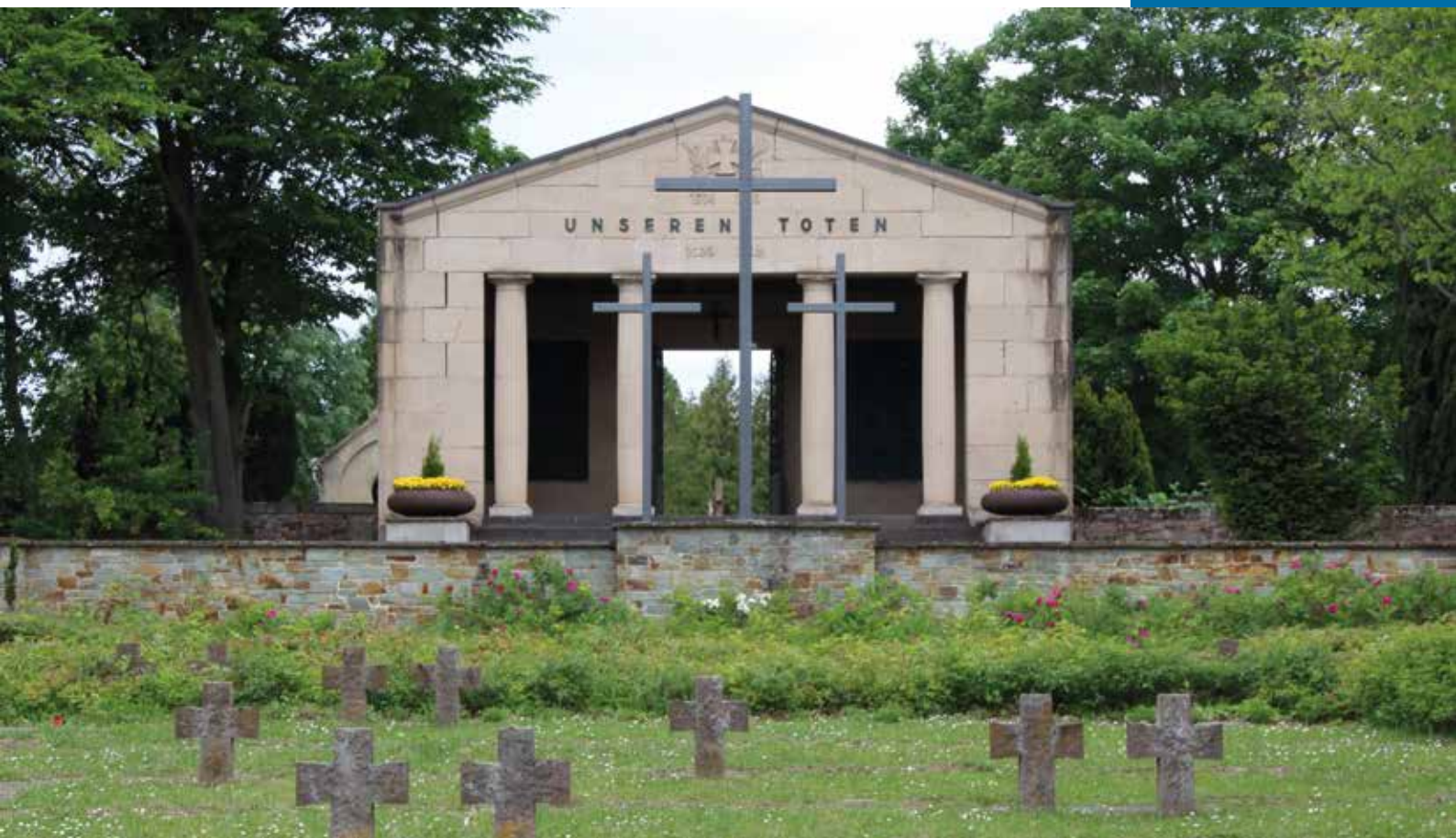
Ehrenhalle von 1927 nach Plänen Georg Hartmanns
