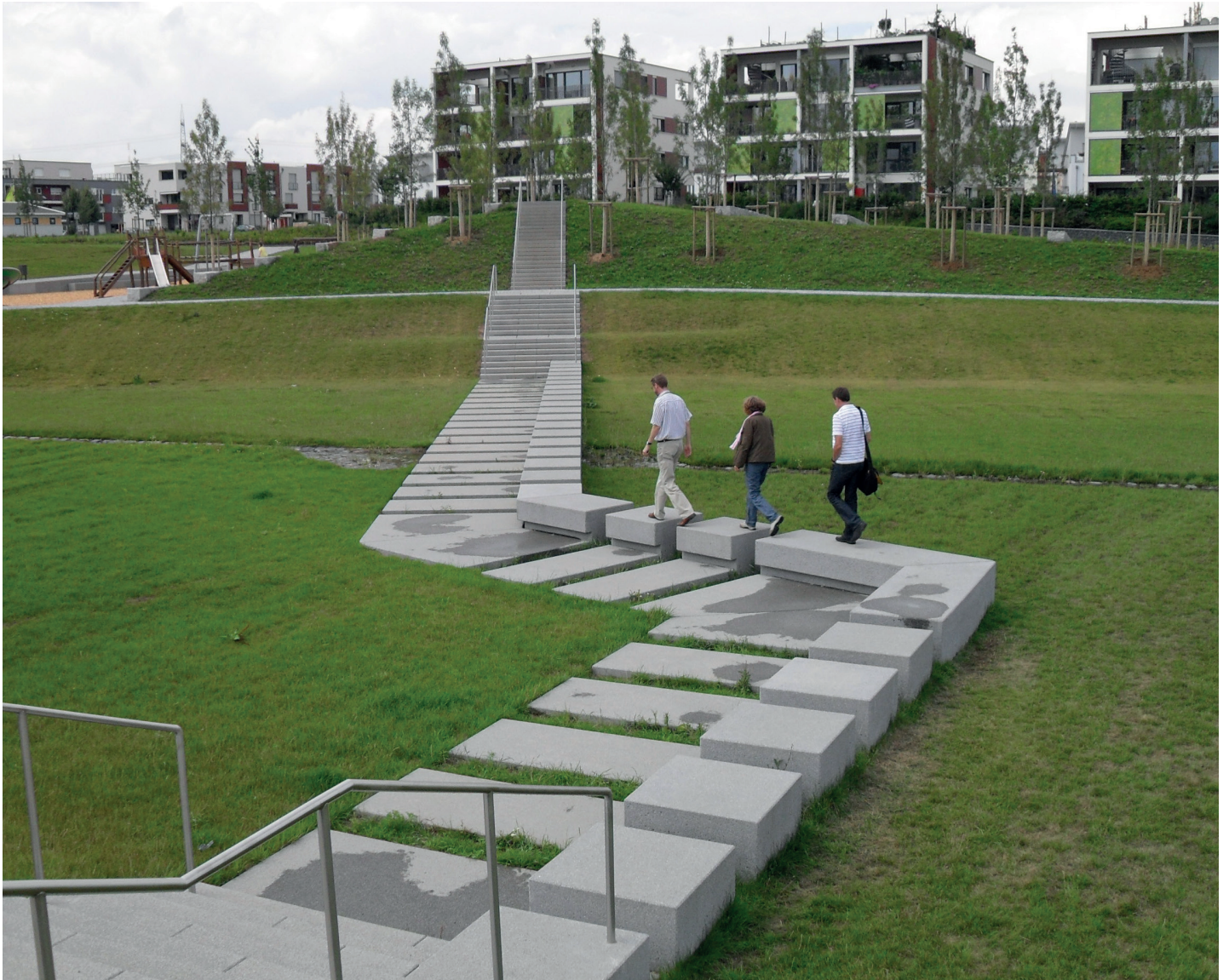
Urbane Rückhalte mulde im Kätcheslachpark mit Trittstein-Querung (Baugebiet Riedberg)
