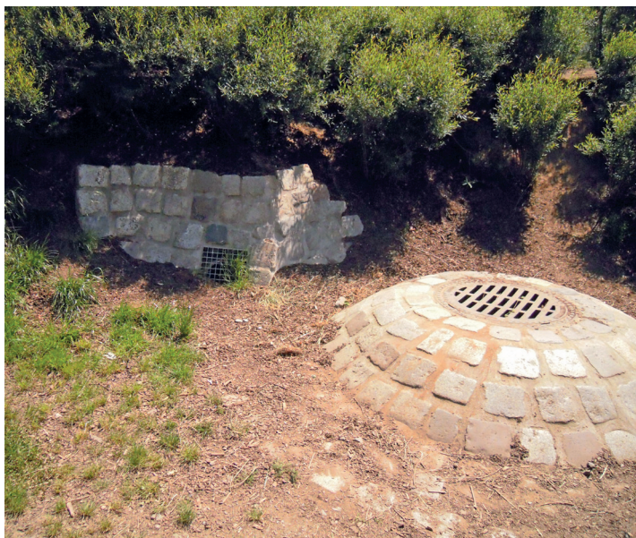
Mulden-Überlauf rechts, ca. 30 cm hoch, Valentin-Senger-Straße (Baugebiet Friedberger Warte/Atterberry)
