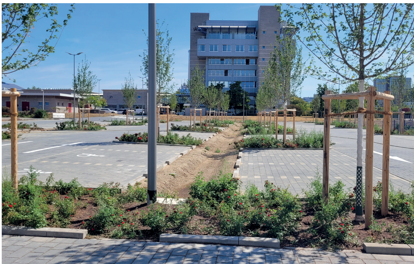
Parkplatz mit Versickerungsmulden nach Ansaat und Bepflanzung (Stadtentwässerung Frankfurt am Main, 2022)
