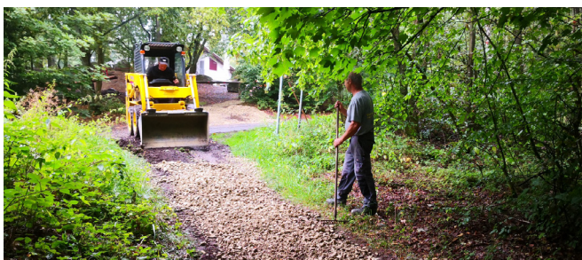
Befestigung einiger Feuchtestellen im Trail durch HessenForst
