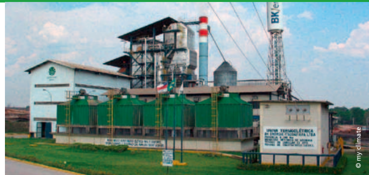
CO 2 -Ausgleichsprojekt Holzschnitzelkraftwerk in Itacoatiara/Brasilien
