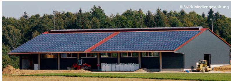
Die 800m 2 große Photovoltaikanlage hilft den Bau zu refinanzieren.
