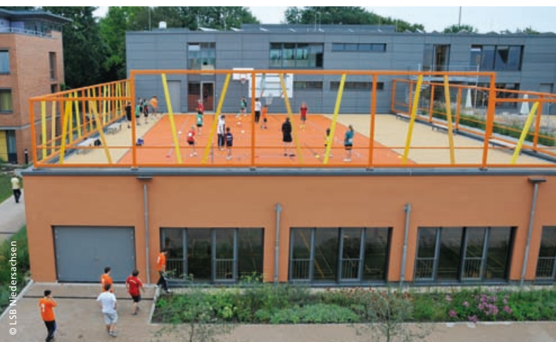
Passivhausbauweise beim Sportinternat des LSB Niedersachsen
