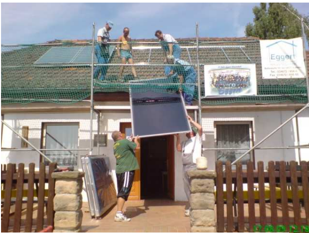
Montage der Solaranlage beim SV Kali Rossleben
