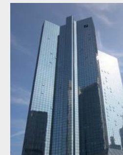
12. DEUTSCHE BANK TWIN TOWERS
