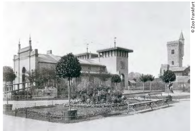
Elefantenhaus und Wasserturm im Frankfurter Zoo. Fotografie 1878
