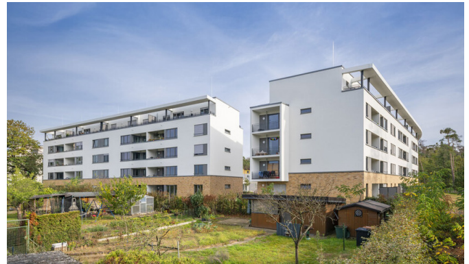
5: Neubau mit Quartiersgarage ©Gregor Schuster
