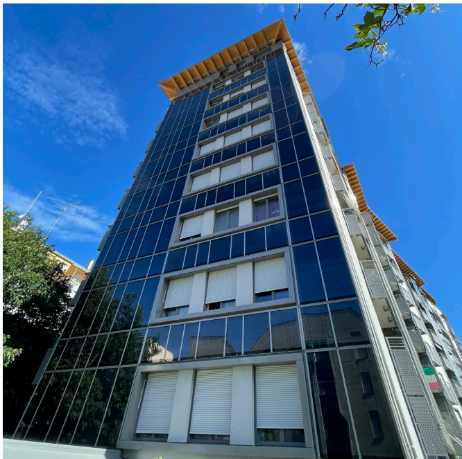
Die Sanierungsarbeiten an diesem Gebäude wurden im bewohnten Zustand durchgeführt. An der Südfassade wurde eine thermische Solaranlage vertikal installiert.
