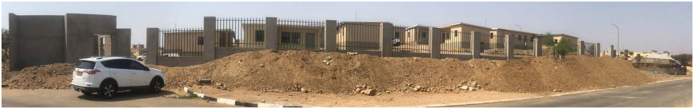
Die neue Siedlung ist von einer Stützmauer und einem Palisadenzaun umgeben.
