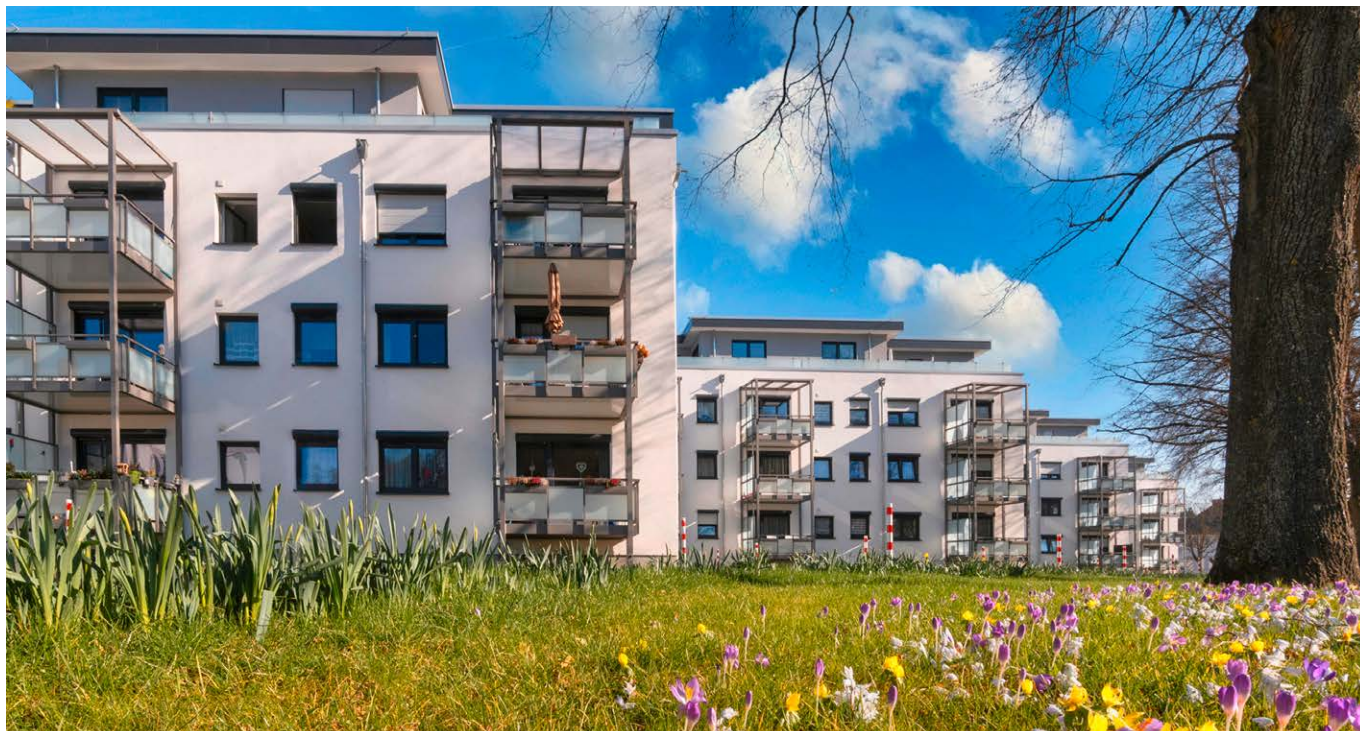
Massive Verbesserung der Wohnqualität: Die sanierten Gebäude erstrahlen in neuem Glanz.
