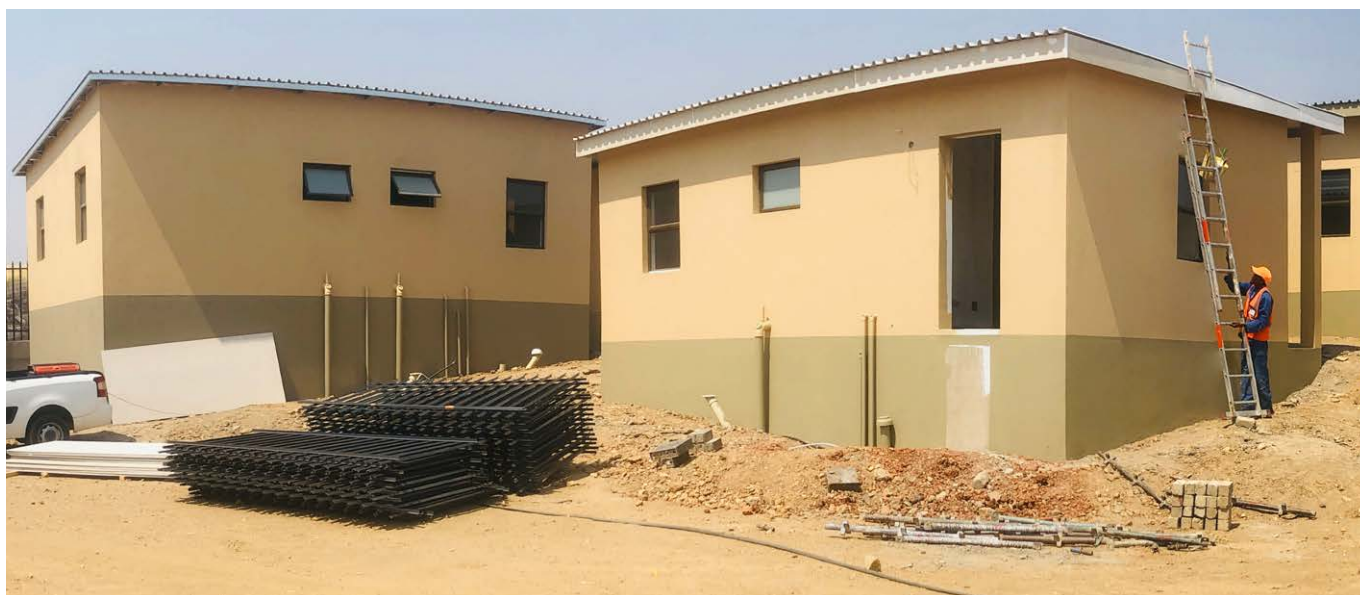
Am Stadtrand von Windhoek in Namibia entstehen Häuser mit einer Wohnfläche von 55 bis 75 Quadratmeter.
