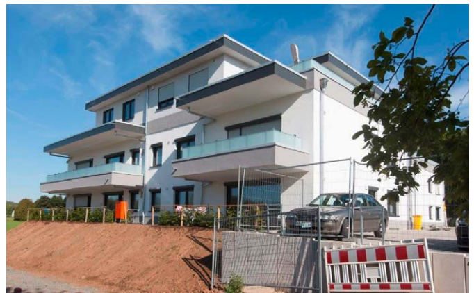
Vorher und nachher: Nach den Sanierungen wirken die Gebäude wie Neubauten und sind wesentlich moderner.
