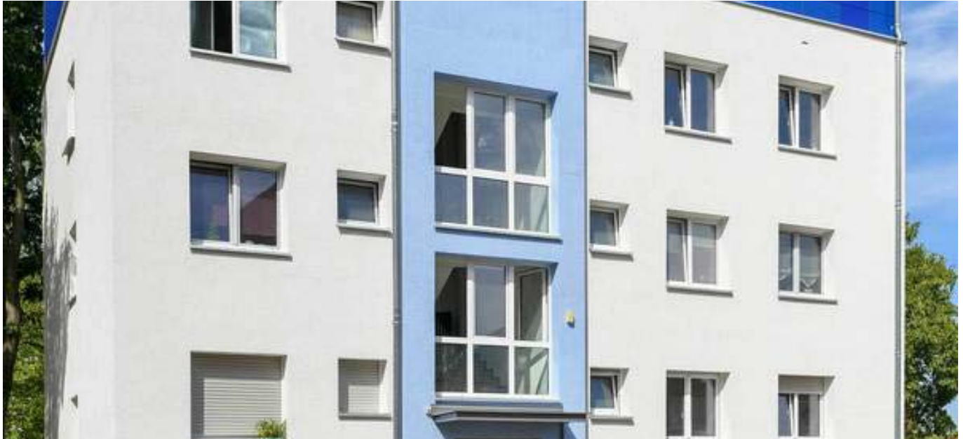
Zusätzlicher Wohnraum: Bei der Aufstockung kamen viele recycelte Materialien zum Einsatz.
