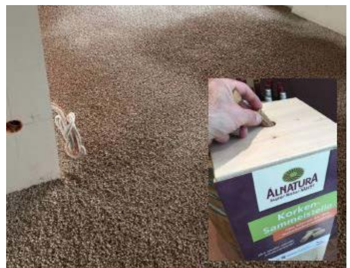
Kork wurde zur Dämmung auf Grobspanplatten verteilt.
