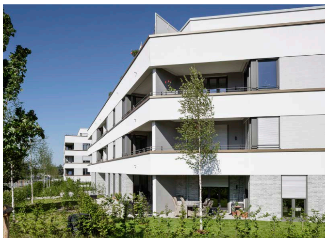
Auf dem Lincoln-Areal sind 141 Wohneinheiten entstanden.
