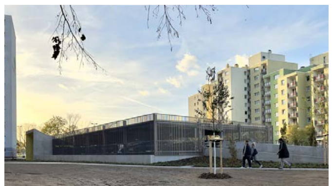
P5 – Ersatzneubau einer Parkpalette für Anwohner © Marc Nehrbaß, SCHOYERER ARCHITEKTEN_SYRA, Mainz
