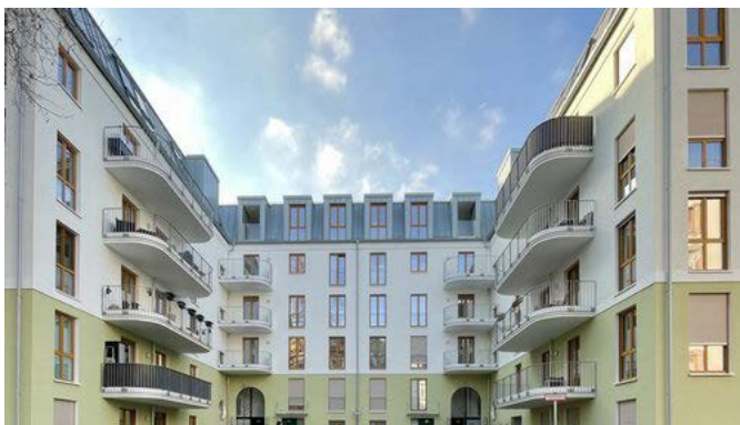
Neubau eines Mehrfamilienwohnhauses in der Freiligrathstraße © Julius Schwarzer, Frankfurt am Main
