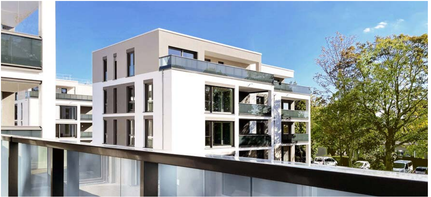
Wohnquartier Thaerstraße © Bitsch+Bienstein Architekten PartGmbB BDA, Wiesbaden
