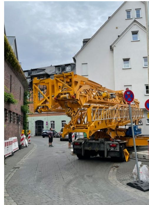
Der Kran musste in die engen Gassen integriert werden.
