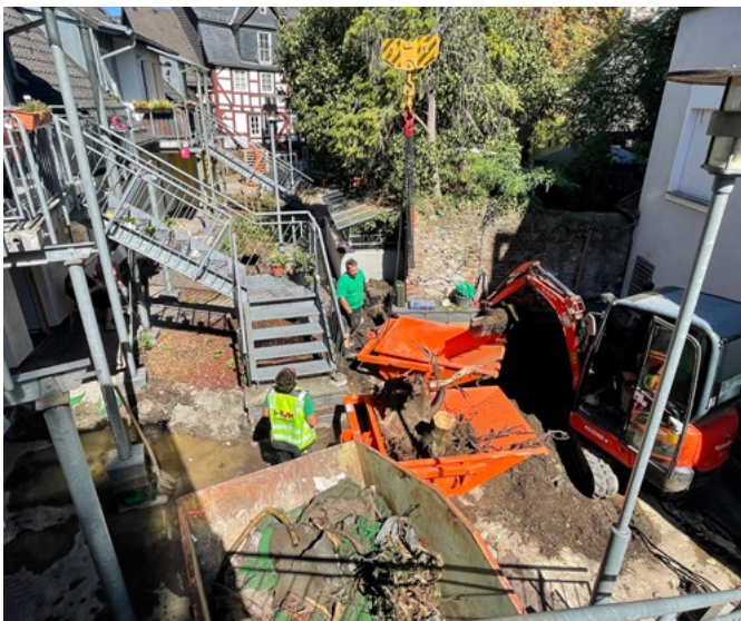
Arbeit auf engstem Raum: die Neugestaltung des Innenhofs.
