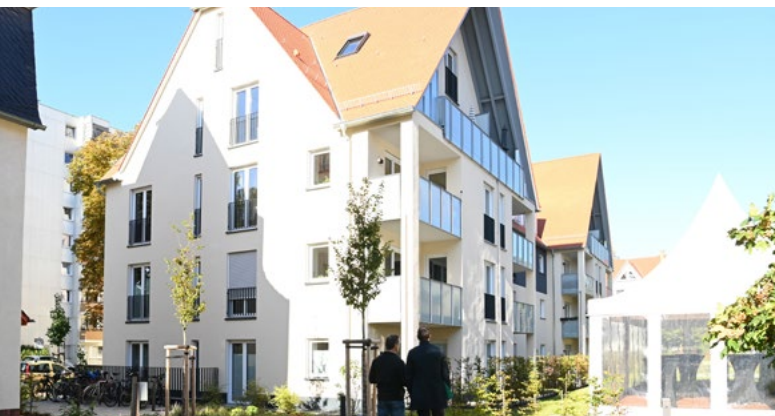
Der Neubau des VBS Frankfurt im Frankfurter Osten.
