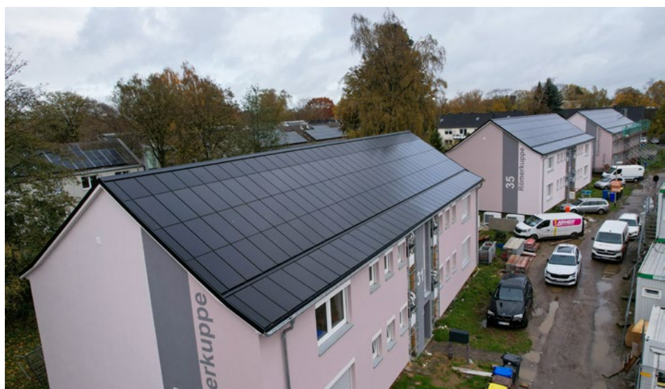
Ennogie-Solardach-Referenzobjekt in Mönchengladbach.
