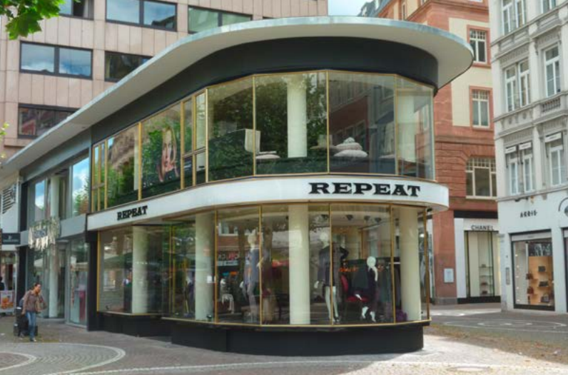
Ehemalige Viktoria Apotheke, Bockenheimer Straße 10 nach Abschluss der Sanierung, 2012
