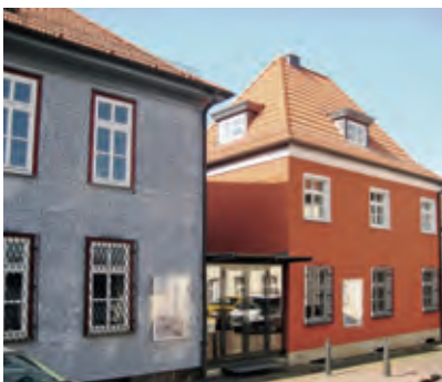
Im Zuge der Sanierungsmaßnahmen wurde das Stadt- und Kreisgeschichtliche Museum Hüfneld erweitert und in Konrad-Zuse-Museum umbenannt.
