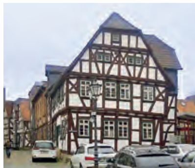
Früher und heute: Das schöne Sicht- fachwerk des neuen Kulturhauses am Kirchenplatz 12 wurde freigelegt und restauriert. Daneben ist mit dem neuen Kulturhaus ein moderner Gebäudekörper geschaffen worden.
