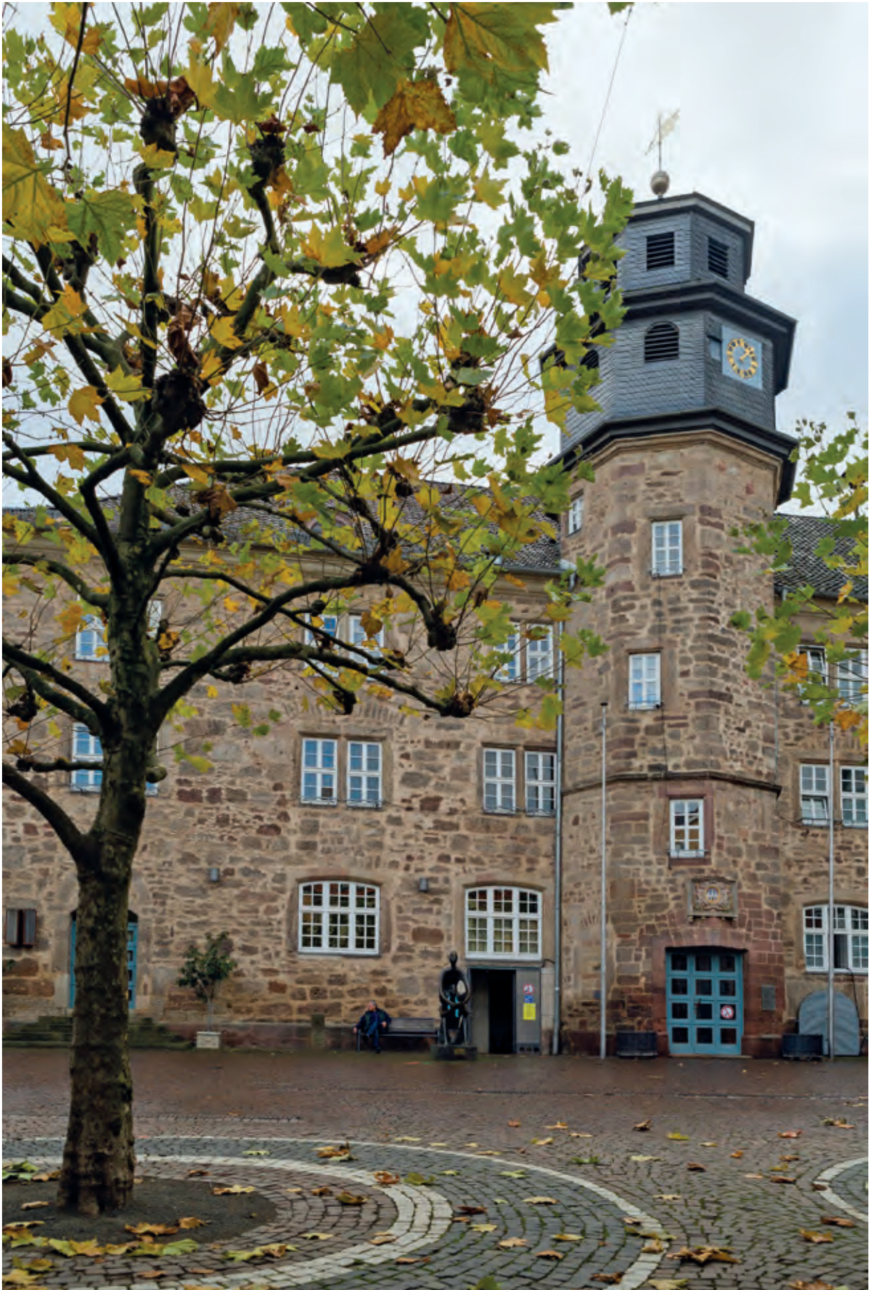
Die Modernisierung des Rathauses gehörte zu den aufwendigsten Maßnahmen innerhalb der Stadtsanierung von Witzenhausen.
