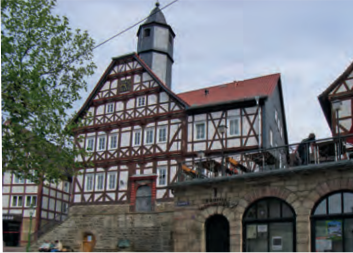
Die Modernisierung und Instandsetzung des Rathauses gehörte zu den wichtigsten öffentlichen Sanierungsmaßnahmen in der Stadt.
