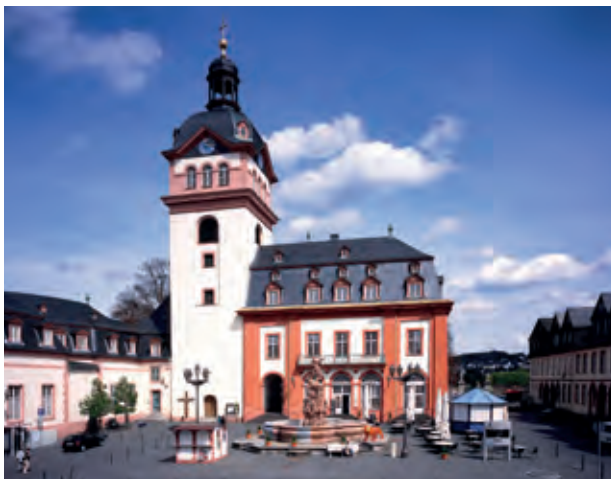
Das Alte Rathaus, das eine bauliche Einheit mit der Schlosskirche bildet, wird seit der Sanierung als Veranstaltungszentrum, Musikschule und Café genutzt.
