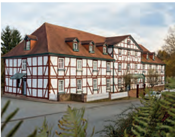
Saniertes Gebäude in der Bahnhofstraße 19–21 mit insgesamt 11 Wohneinheiten
