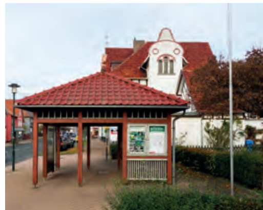
Der Rückbau der Bundesstraße gehörte zu den wichtigsten Erschließungsmaßnahmen in Reichensachsen.
