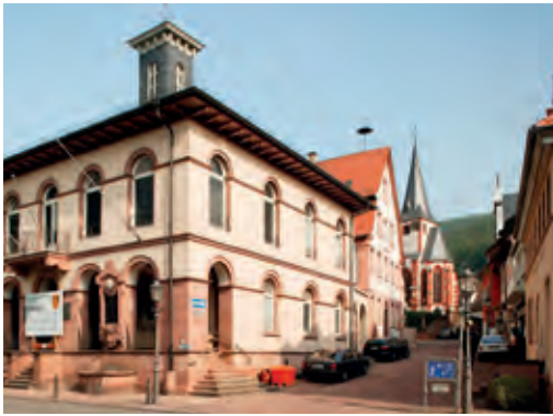
Das historische Rathaus von Neckarsteinach strahlt in neuem Glanz.
