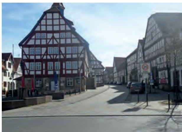
Der Platz vor dem historischen Rathaus wurde ebenso wie das Kirchenumfeld altstadtgerecht gepflastert und barrierefrei erschlossen.
