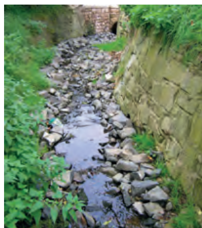
Eine besondere Herausforderung war die naturnahe Umgestaltung der Steinrute im Jahr 2005. Neben der teilweisen Freilegung des Bachlaufs im Altstadtbereich umfasste die mit Mitteln der Stadt-sanierung und des hessischen Landesprogramms „Naturnahe Gewässer“ realisierte Maßnahme auch die Sanierung der Brücken sowie eines Durchlasses unter den Häusern Hohe Straße 22 und 23.
