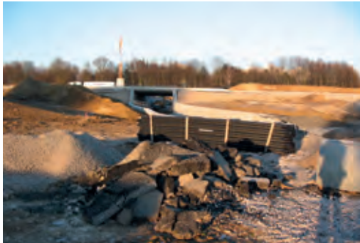
Eschborn: Trogbauwerk zur Anbindung an die L 3005.
