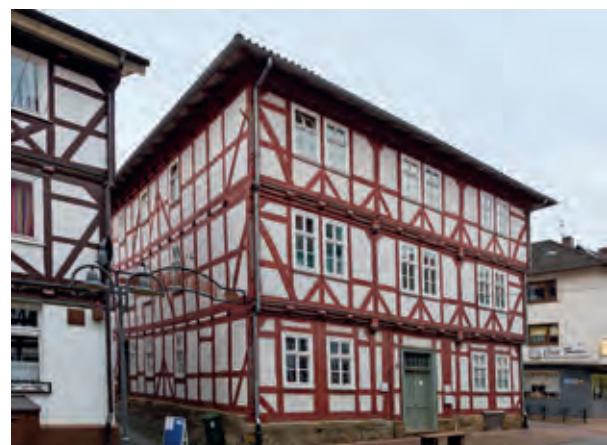
Eines der auffälligsten Fachwerkhäuser in Sontra ist das denkmalgeschützte Ärztehaus in der Niederstadt 16. Es hat als eines der wenigen historischen Gebäude einen Stadtbrand im Dreißigjährigen Krieg überstanden.
