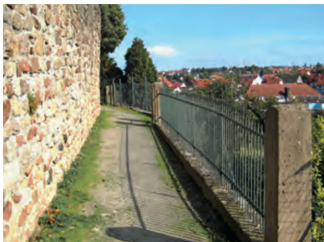
Durch den Ausbau des Hainmauerweges zwischen der Innenstadt und den umliegenden Privatgärten konnte eine fußläufige Verbindung mit Aufenthaltsqualität geschaffen werden.
