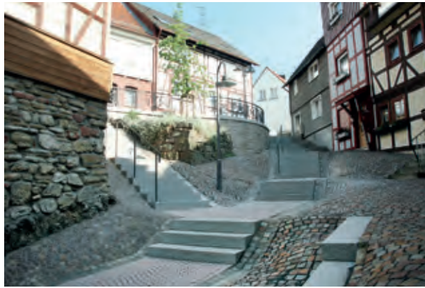
Die neue Fußwegtreppenanlage Am Mühlrain gehört zu den besonders gelungenen Erschließungsmaßnahmen.
