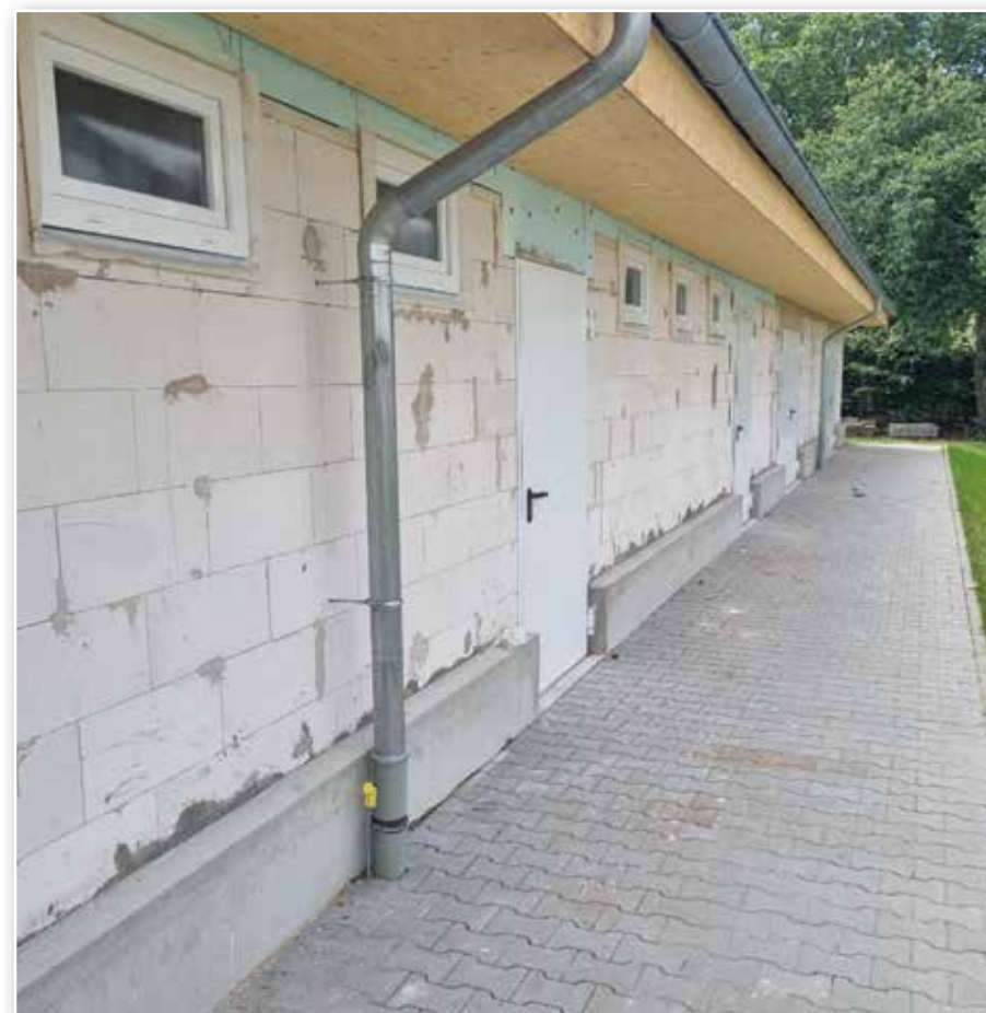
Außenansicht der neuen Umkleidekabinen und Lager. Die Verkleidung der Fassade wird in den nächsten Wochen erfolgen
