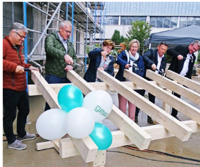
Symbolische Hammerschläge durften beim Richtfest nicht fehlen.
