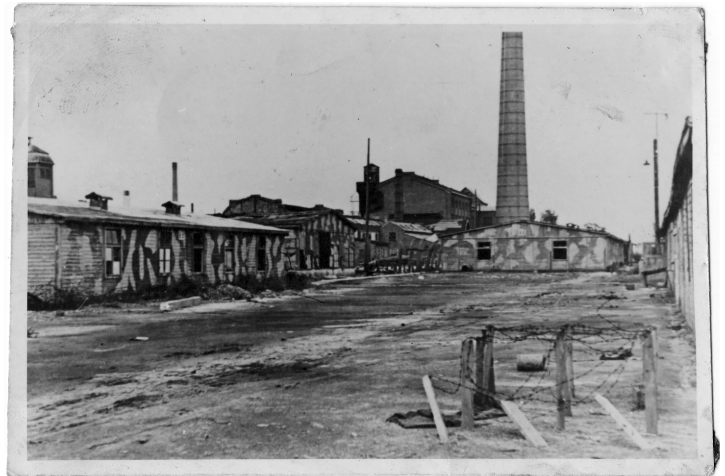
Unten: Baracken des Zwangsarbeitslagers im HASAG-Werk »Pelcery« in Częstochowa/Tschenstochau nach der Befreiung, vermutlich Frühjahr 1945. Foto: USHMM, ID: Collections 2014.514.1
