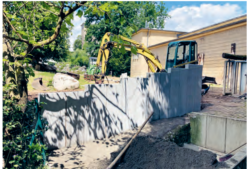
Die alten Holzpalisaden auf der Nashornanlage müssen weichen (oben) und werden durch stabilere Betonwinkel ersetzt.
