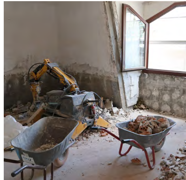
Vorbereitende Arbeiten in den Obergeschossen des Spenerhauses
