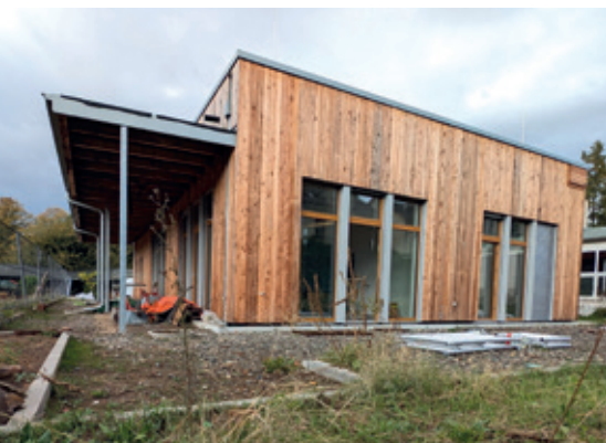
Das Seminargebäude ist fast fertig.
