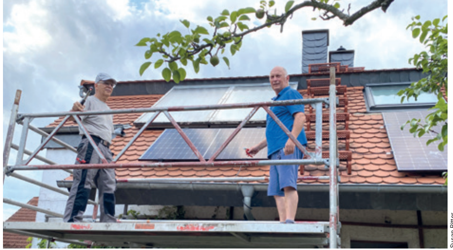
AMU-Aktive bei der PV-Installation
