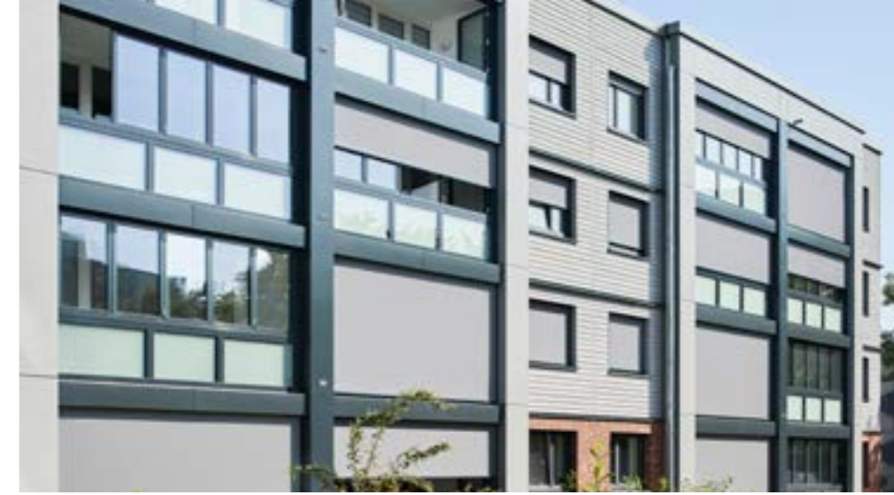
Vorgehängte Faltschiebe-Fenster aus Aluminium werten die Loggien zu ganzjährig nutzbarem Wohnraum auf und stellen die Förderfähigkeit des Projekts sicher.
