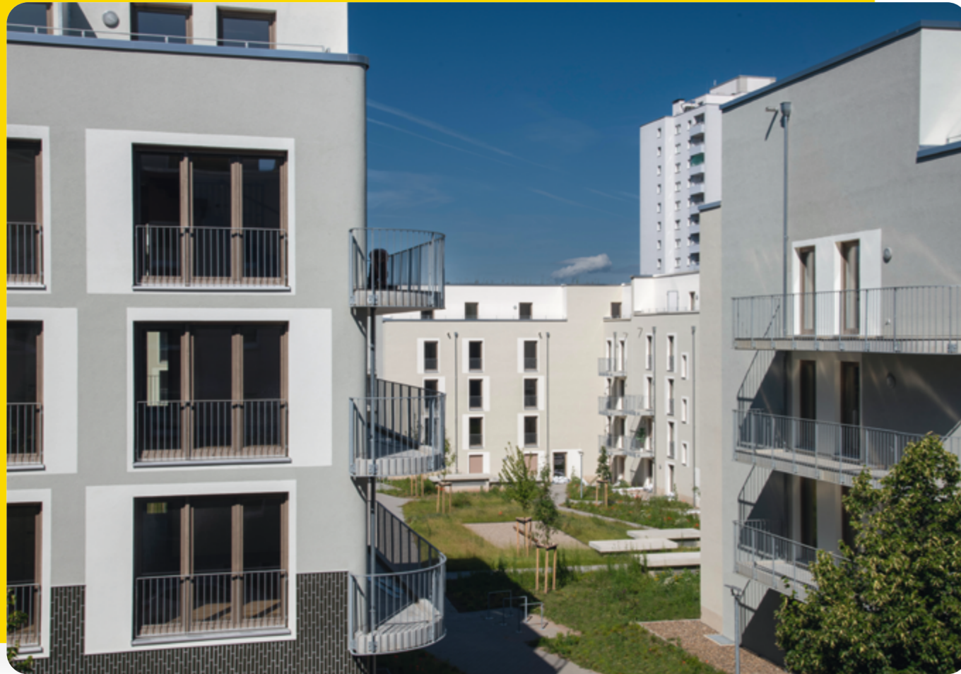
In 2024 fertiggestellt: Das Bauprojekt „Kantapfel-/Goldpeppingstraße“
