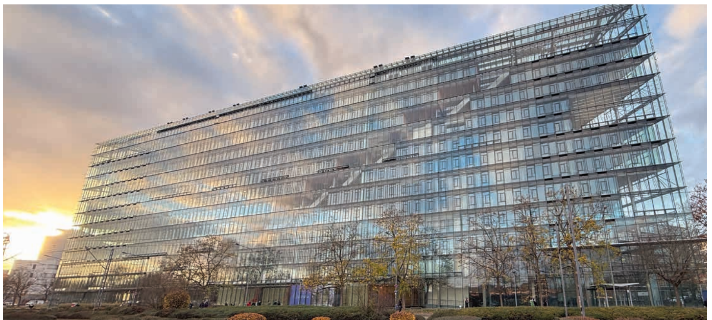
Außenansicht des Prisma im Frankfurter Lyoner Quartier: Die durchgängige Glasfassade und die markante Gebäudekante prägen das Quartier. Die Revitalisierung setzt auf Transparenz, Energieeffizienz und eine klare architektonische Haltung im Bestand.
