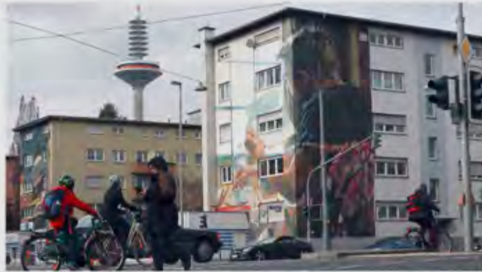
Die Deutsche Wohnen lässt in der Carl-von-Weinberg-Siedlung an der Miquelallee in Frankfurt rund 60 Wohnungen leer stehen. © ROLF OESER
