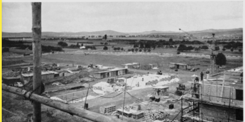
Baugelände der Wohnanlage „Sossenheim Nord-West”. Im Hintergrund der Taunus. Building-site of the “Sossenheim Nord-West” housing estate. In the background, the Taunus Mountains. Terrain de construction pour la colonie d’habitation «Sossenheim Nord-West». Au fond, le Massif du Taunus.
