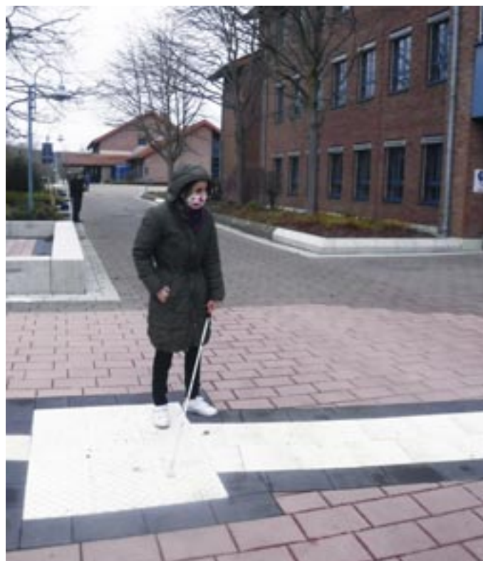
Schulgelände mit Leitstreifen
