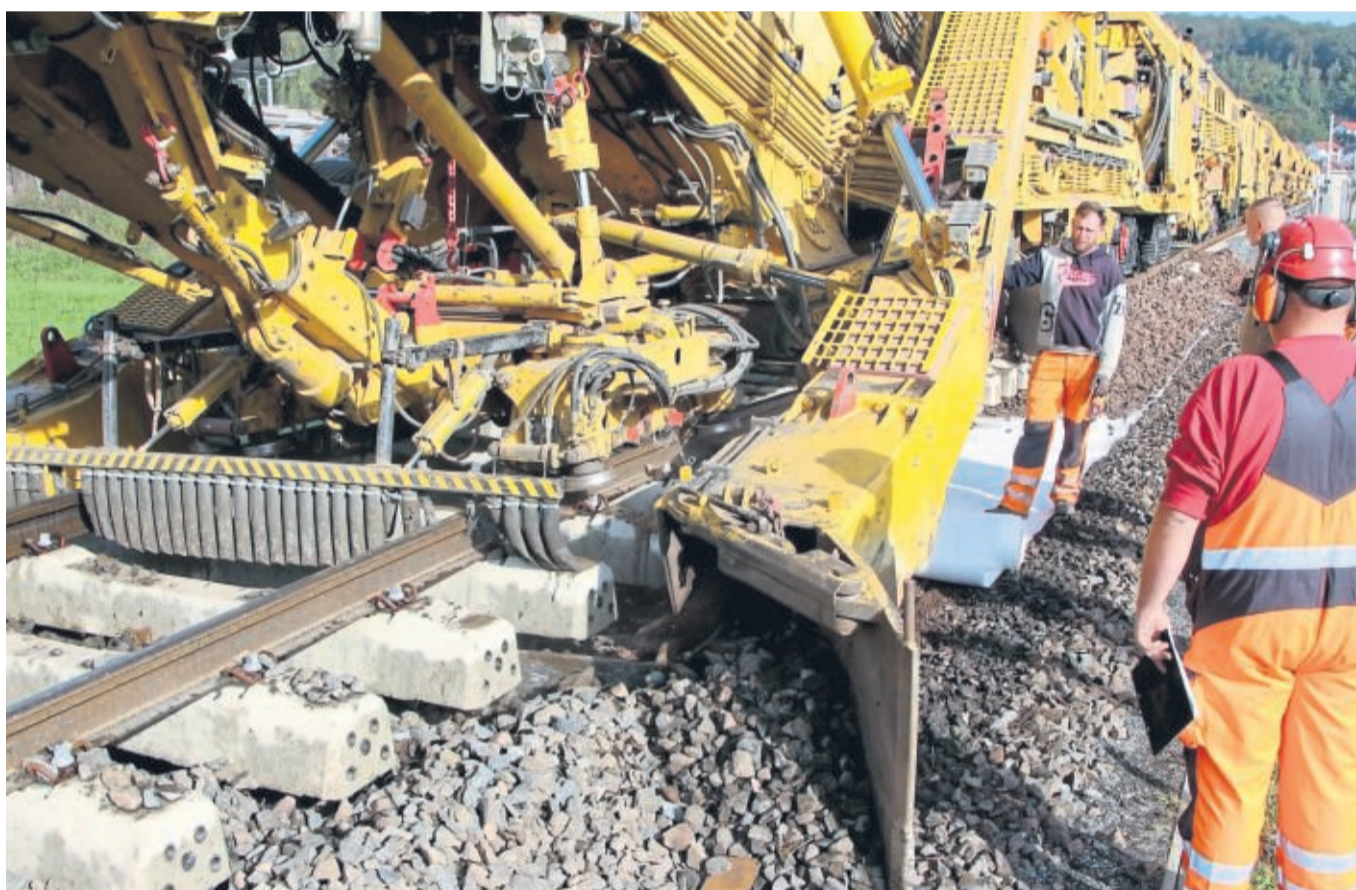
Gleisumbauarbeiten: Ein mächtiger Bauzug erneuert auf der Bahnstrecke zwischen Frankenberg und Viermünden (Foto) Schienen, Schwellen und Schotter. Das Vlies soll Feuchtigkeit aus dem Gleisbett zurückhalten. FOTO: KLAUS JUNGHEIM
