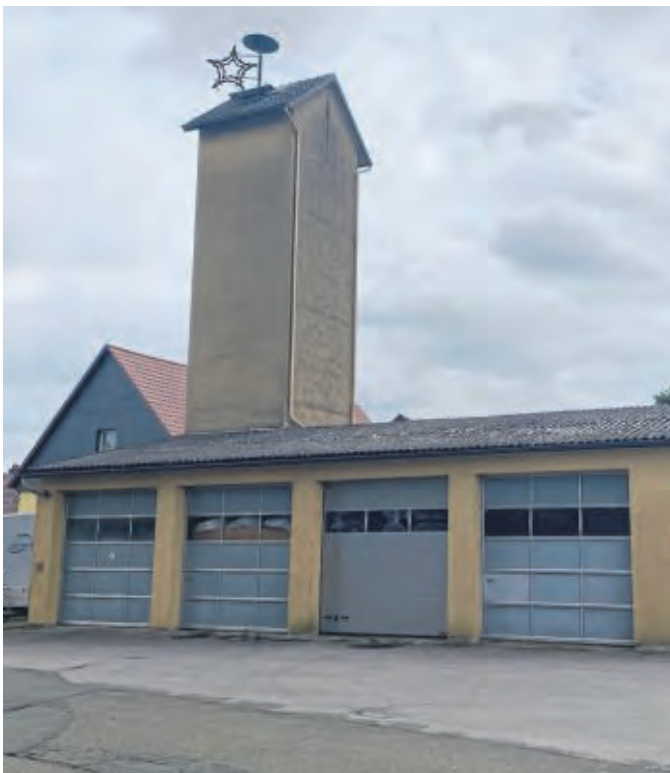
Mehrere Feuerwehrhäuser in Diemelstadt müssen saniert oder erneuert werden. Hier der Feuerwehrstützpunkt in Rhoden mit dem Schlauchtrockenturm. FOTO: SCHULTEN
