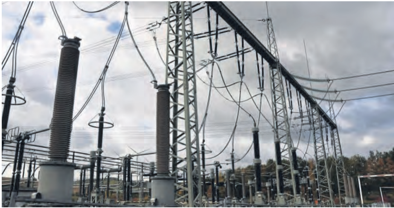
Bauarbeiten am Umspannwerk zwischen Mengerlinghausen und Twiste: Hier ist die Schnittstelle zwischen dem regionalen 110- und dem europäischen 380-Kilovolt-Stromverbundnetz. FOTOS: ELMAR SCHULTEN
