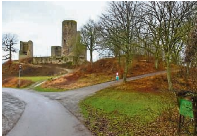
Die Kugelsburg Volkmarzen soll als touristisches Ziel attraktiver gestaltet werden. Das Mauerwerk benötigt eine Sanierung.
