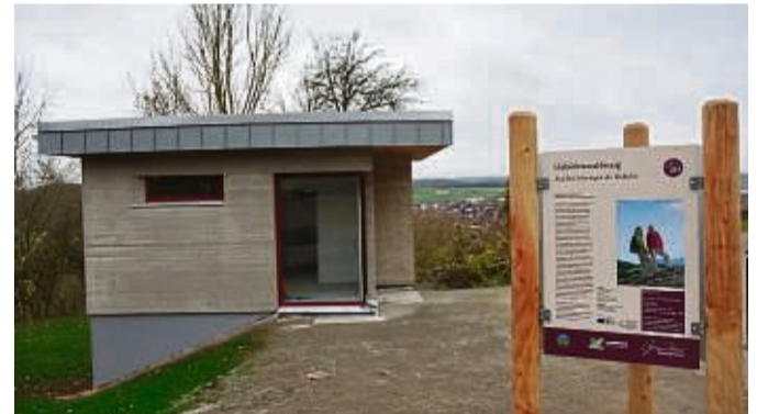
Das Servicegebäude an der Kreuzung von Wanderwegen dient als WC und bietet im Keller Lagermöglichkeiten.
