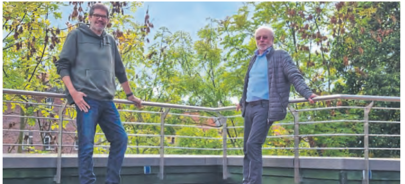
Wie auf einem Schiff: Eine der bugartigen Dachterrassen mit Reling soll an das Sonnendeck eines Kreuzfahrtschiffes erinnern. „Ich finde, unser Hotel liegt wie ein Schiff an der Werra“, sagt Investor Dieter Kühnemund (rechts). Finn Godenrath betreibt mit seiner Frau Hotel und Restaurant.
