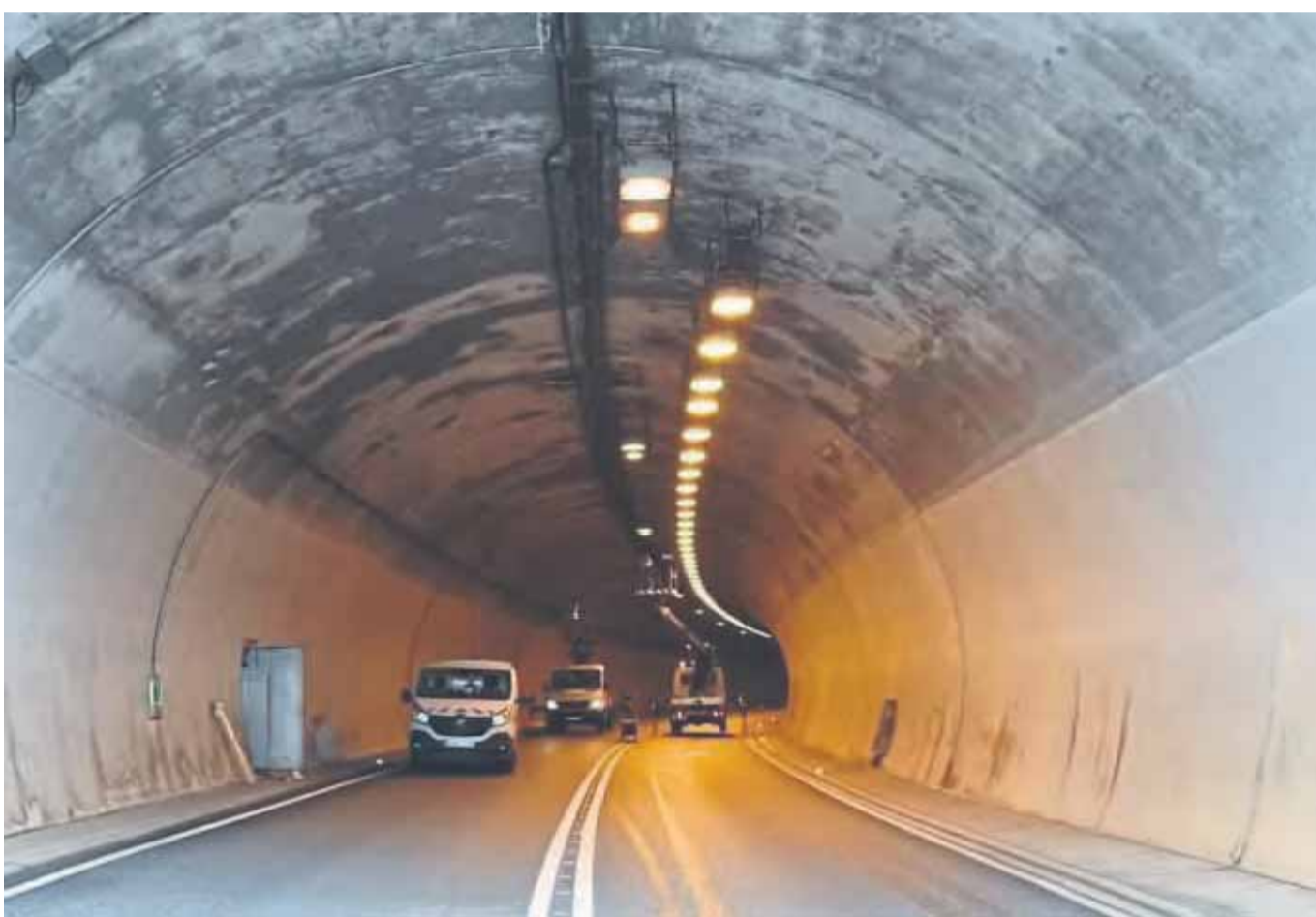
Wird vorübergehend gesperrt: Der Schürzebergstunnel bei Oberrieden wird als erster Tunnel in Hessen mit neuer Technik ausgerüstet. FOTO: NICO BECK
