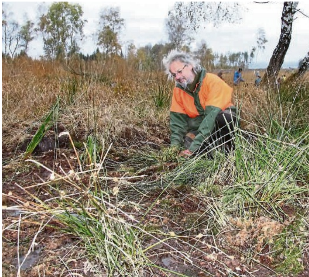
Projektleiter Lutz Rohland auf einer bearbeiteten Fläche: Im Untergrund haben die Helfer eine hölzerne Sperre eingebaut, die den Wasserabfluss verhindert. Nach der Bepflanzung sieht man nichts mehr davon. Die Flatterbinsen halten mit ihren Wurzeln die Grabenverfüllung fest und stören die Torfmoose nicht im Wachstum.
