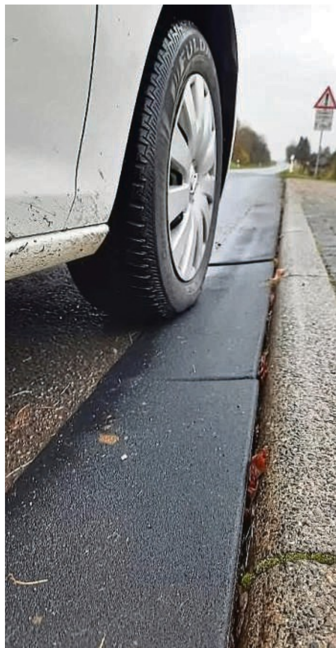
Mobile Bordsteinrampen können gerade im Winter gefährlich werden, warnt Hessen Mobil. FOTO: HESSEN MOBIL
