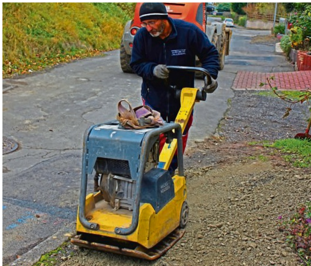
Wasserleitung verlegt: Unser Bild zeigt Fakim Özdemir, Mitarbeiter der beauftragten Fachfirma, bei Abschlussarbeiten mit einem Rüttler, mit dem der Boden verdichtet wird.
