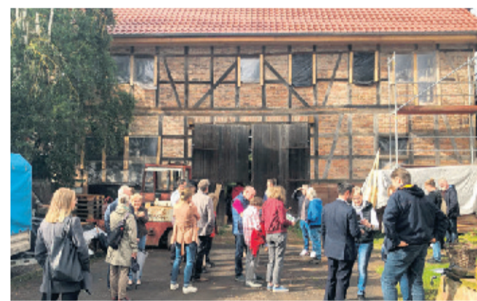
Sebastian Fawier mit Teilnehmenden vor der Scheune im Umbau. FOTO: IPU ERFURT
