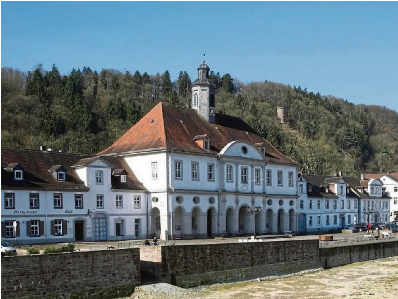
Müssen repariert werden: Dach und Fassade des barocken Rathauses in Bad Karlshafen.
