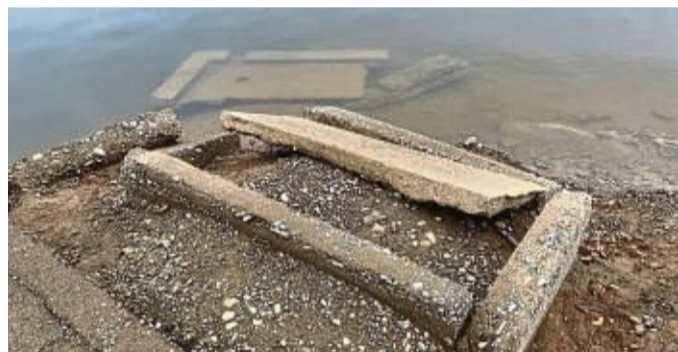
Abgerutscht: Grabplatten auf dem Gräberfeld.
