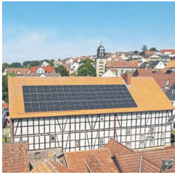
Gemeindeverwaltung arbeitet mit Solarstrom: Auf der Rathaus-scheune wurde eine Fotovoltaikanlage installiert.
